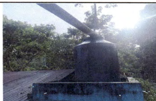
Foto 4: Estructura de tanque de agua en mal estado por humedad
